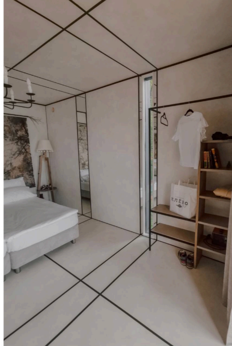
Отель в Новой Москве. Стеновые панели СМЛ со скрытым креплением
